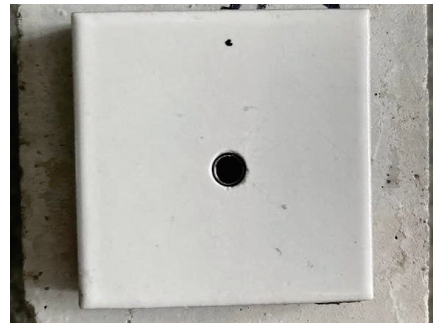
写真-1 板厚 0.4mm の C 型を挿入後のタイル表面
